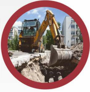
Korszerű távvezeték építése
