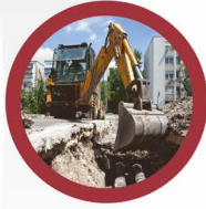
Korszerű távvezeték építése
