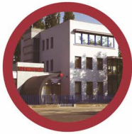
Fűtőművek modernizálása I.
